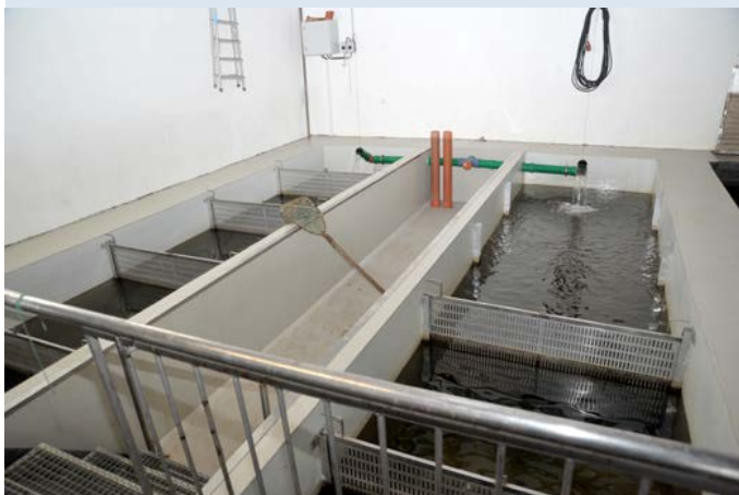
Der hintere Bereich der Hälterung wurde zu einer kleinen Anlage mit zwei Rinnen für den Versand und Direktverkauf der Fische umgebaut.
